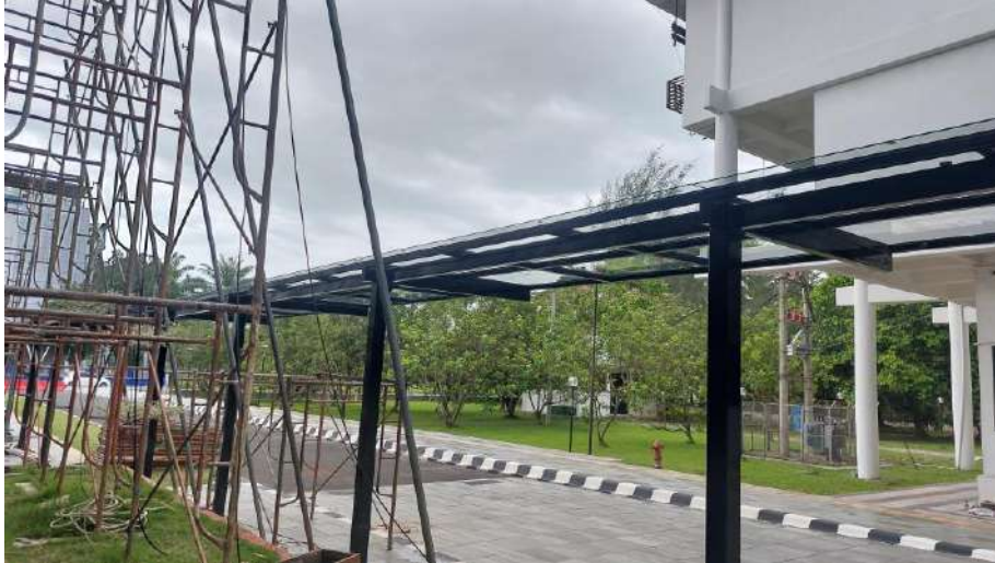
Finishing Pekerjaan Selasar DLCB
