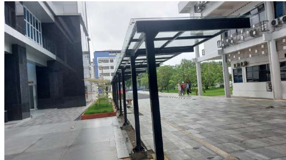
Finishing Pekerjaan Selasar DLCB
