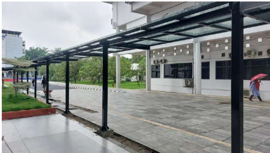
Finishing Pekerjaan Selasar DLCB
