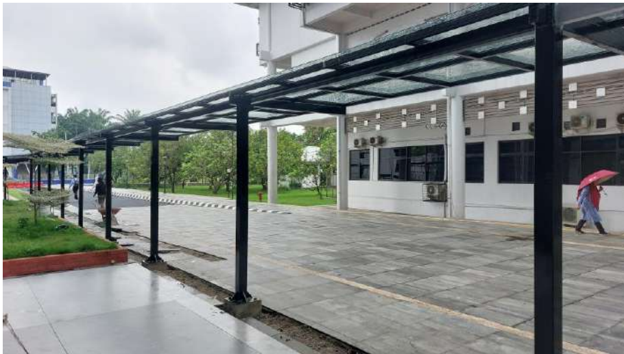
Finishing Pekerjaan Selasar DLCB
