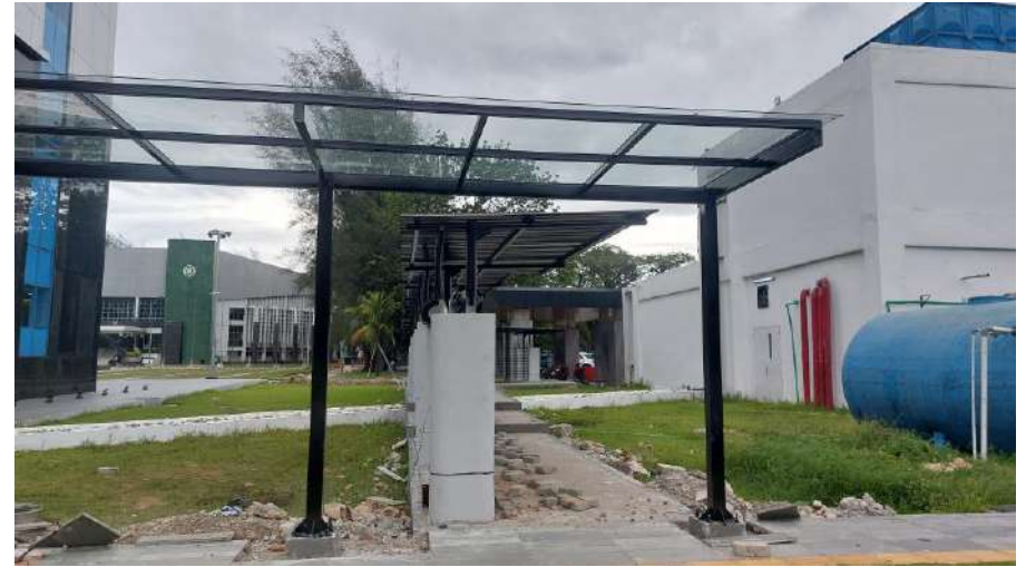
Finishing Pekerjaan Selasar DLCB
